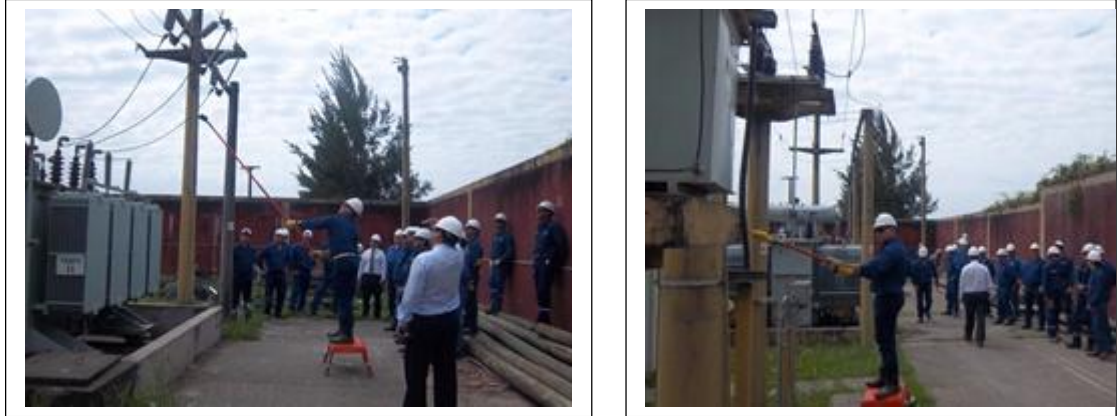
Fig.10 Demostración de Verificación en transformador de 33 Kv a 13, Kv
