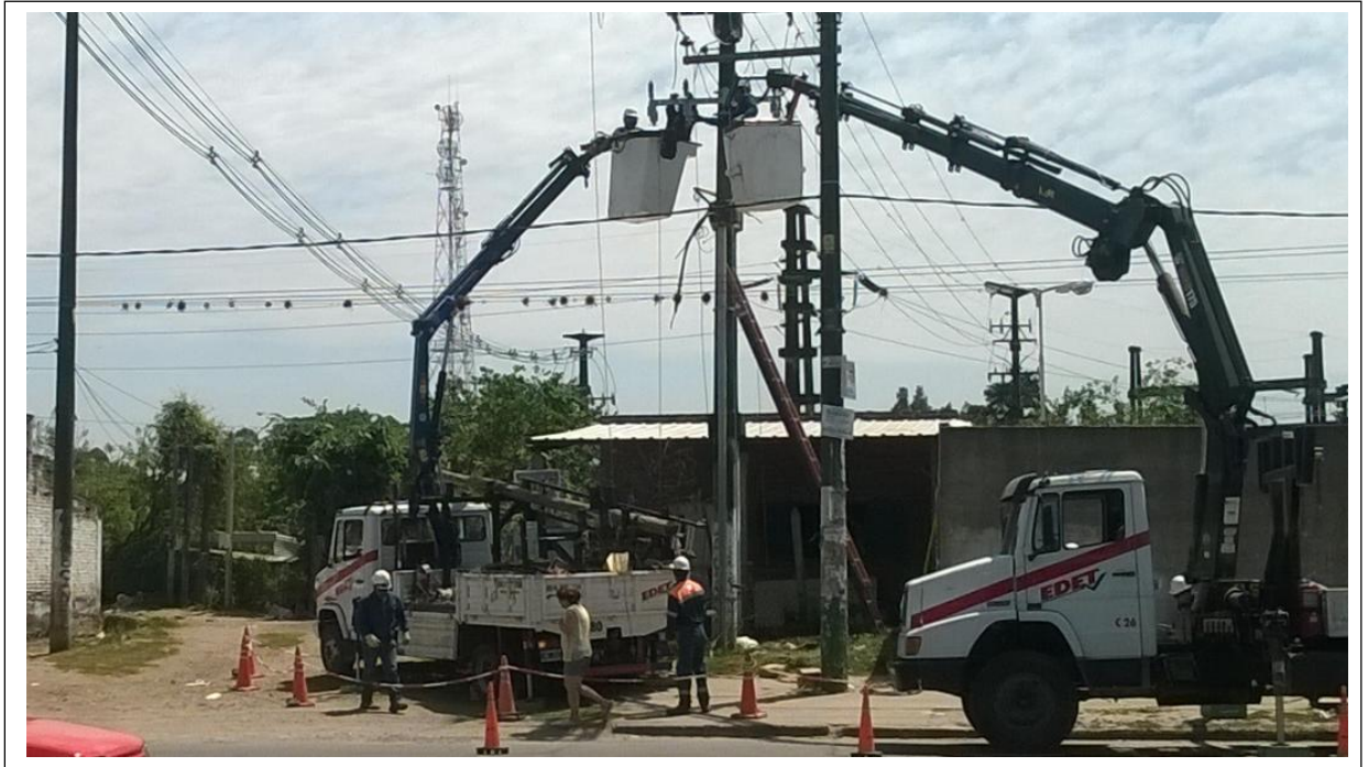
Fig.16 Zona de trabajo Señalizada
