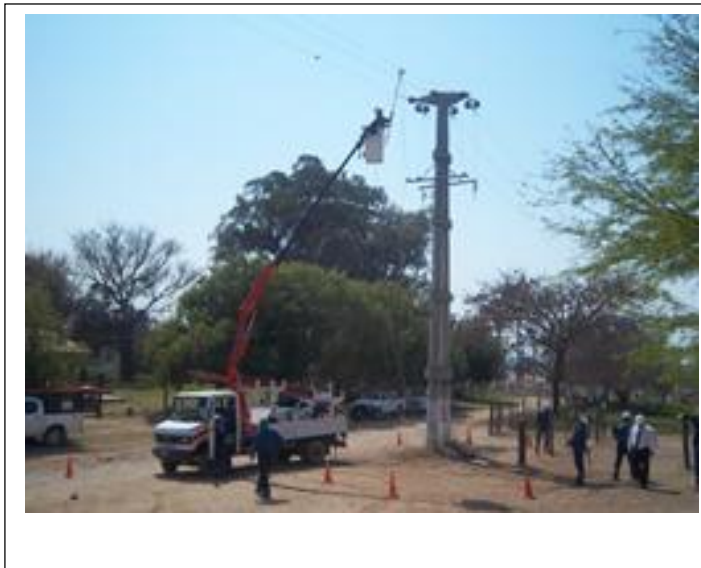
Fig.12 Conexión de PAT en LMT
