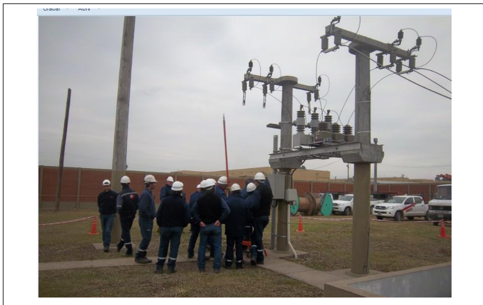
Fig.21 Verificación del Trabajo en Terreno
