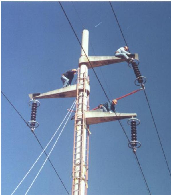
**Separación del conductor de fase superior**
