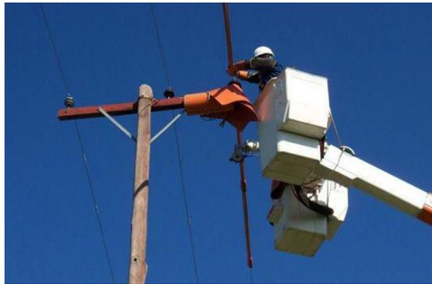
**Figura 8.2.1 – Método a contacto**
