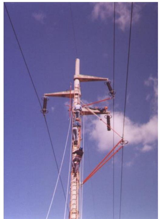
**Desenganche de conductor y separación de cadena de aisladores**
