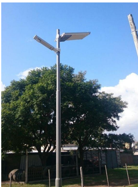
Fig. 7. Ejemplo de instalación de una luminaria solar con panel separado
