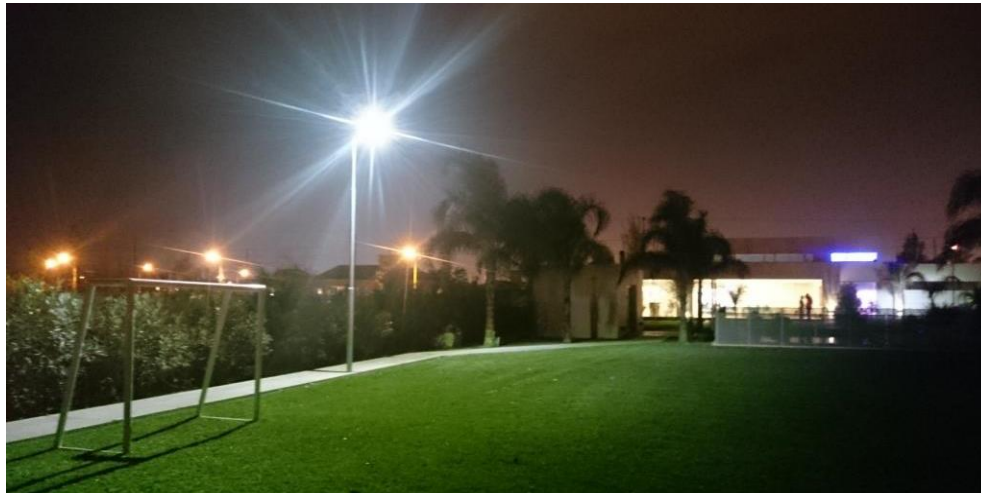
Fig. 2. Ejemplo de implementación de una luminaria solar con panel solar integrado
