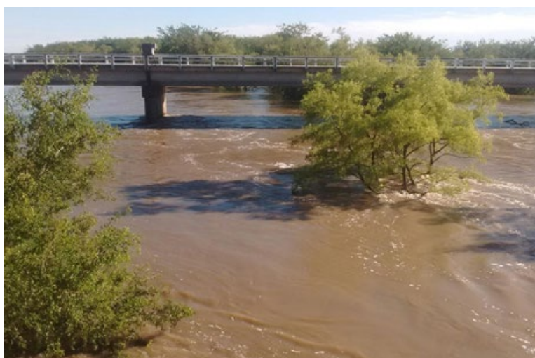
Figura 1.5: Crecida arroyo Nogoyá. Ruta Nacional N°11. Febrero 2016
