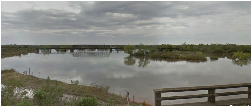
Figura 2.6- Vista aguas abajo del río Gualeguay en cruce con Ruta Nacional N°18.
