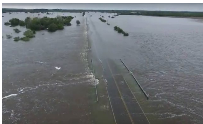
Figura 1.1: Desborde arroyo Feliciano sobre Ruta Nacional N°12. Abril 2016
