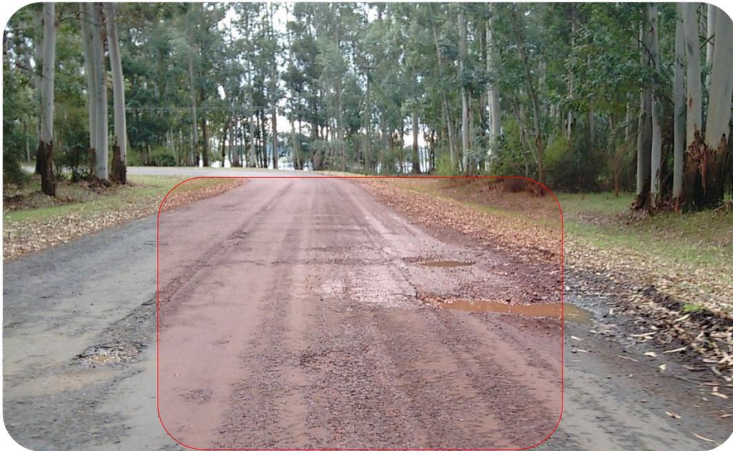
*Imagen 9: Pérdida de agregado (PA) y Desgaste superficial (DSU)*
