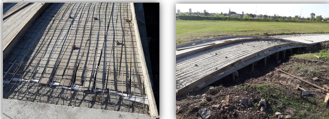
FIGURA 27: Encofrados y armaduras en puentes peatonales
