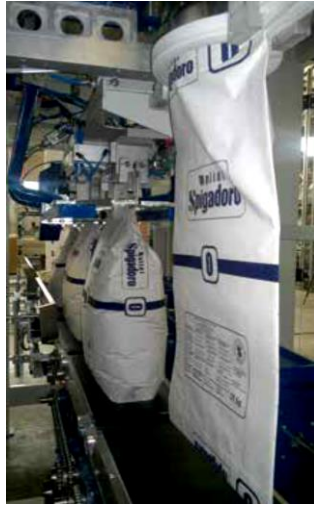
Figura N°49: Boquilla de llenado con mordazas de agarre y cinta transportadora vibradora inferior.
