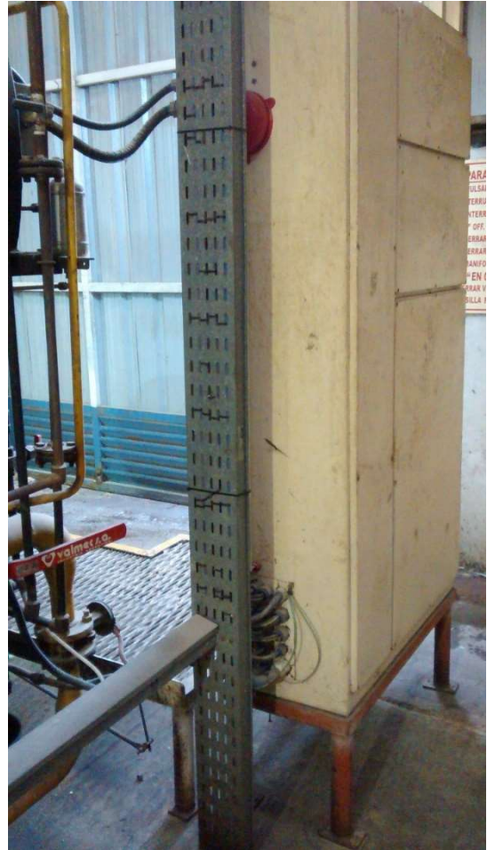
Figura 6 Bandejas portacables
