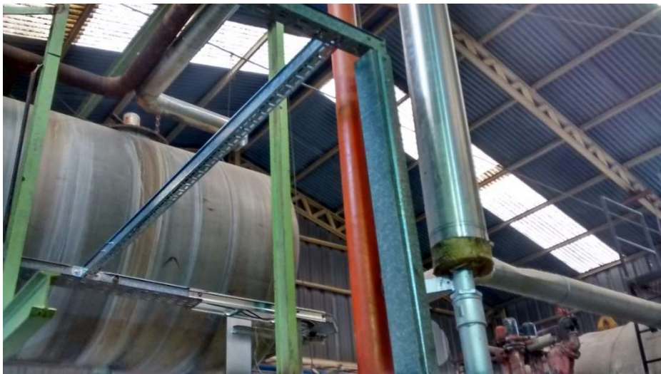
Figura 2 Recorrido cables de señal
