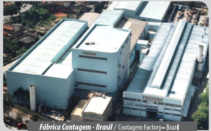
Fábrica Contagem - Brasil / Contagem Factory - Brazil
