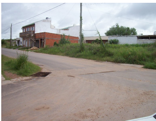
Figura 7.17: Alcantarilla existente intersección de calles Urquiza y las Glicinas
