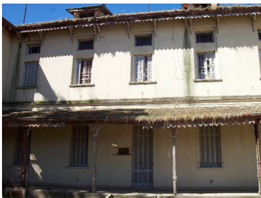
Figura 3.17: Techos de galerías
