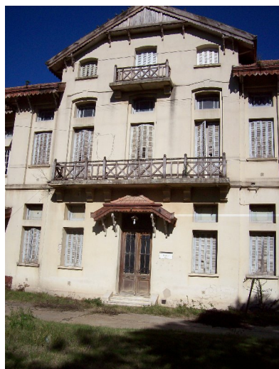
Figura 3.15 Parte de la fachada
