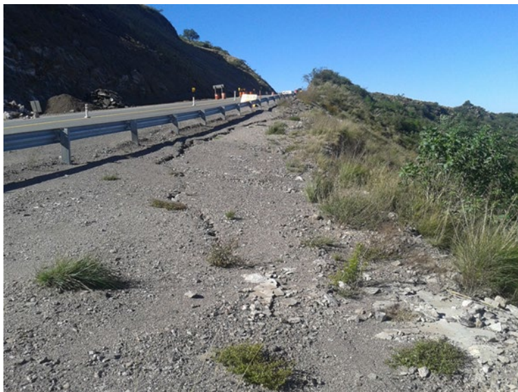
Figura 40.3: Formación inicial de una cuña de falla, con riesgo potencial de deslizamiento de talud, en un camino de montaña
