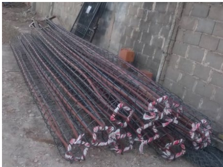
Figura 36.2: Pilote excavado con inyección de precarga. Cañerías vinculadas a la armadura, previo a la instalación.
