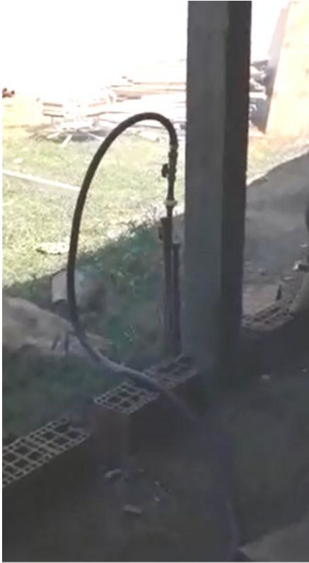
Figura 36.6: Inyección de precarga en un pilote excavado
