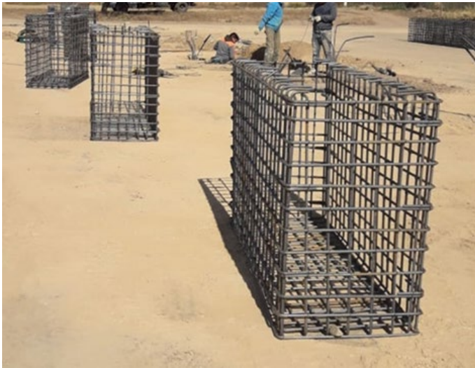
Figura 39.2: Construcción de cabezal. Secuencia: (i) limpieza, (ii) instalación de armadura, (iii) canasto
