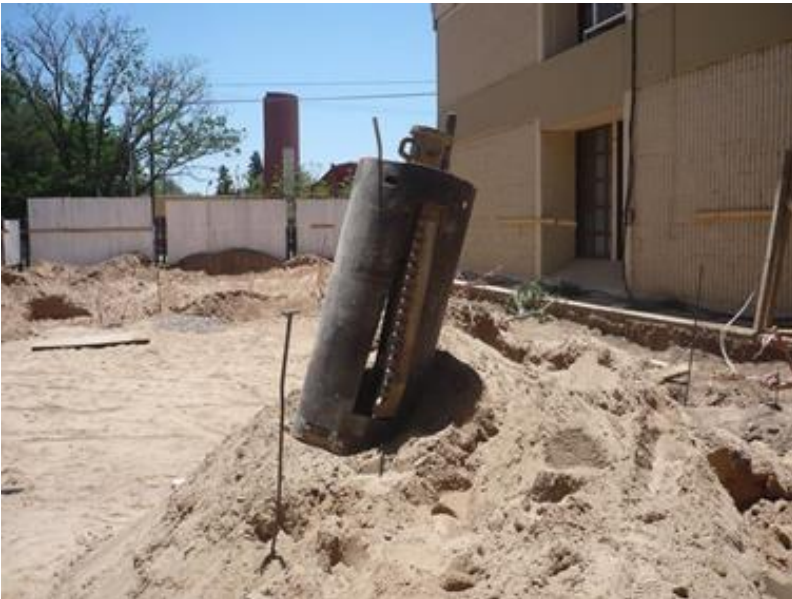
Figura 35.3: Útil expansor o “campanero”
