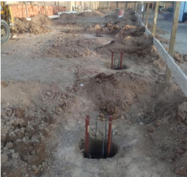
Figura 36.3: Pilote excavado con inyección de precarga. Armadura y cañerías instaladas en la perforación.
