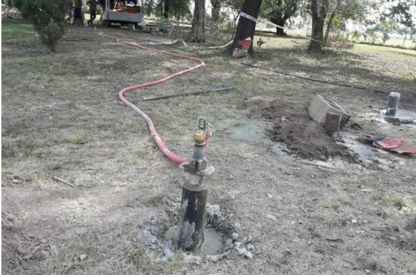
Figura 35.8: MHI en proceso de inyección
