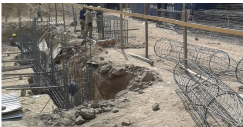
Figura 39.3: Fotografías de armadura de pilotes y cabezal para grupo de dos pilotes. Edificio de la carrera de ingeniería civil, UTN FRC (septiembre, 2016)
