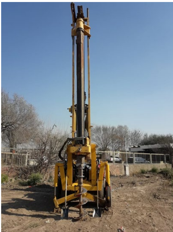
Figura 35.1: Excavadora de pilotes. Posición de inicio con mecha helicoidal (GEF: Consultoría en Geotecnia, Estructuras y Fundaciones )
