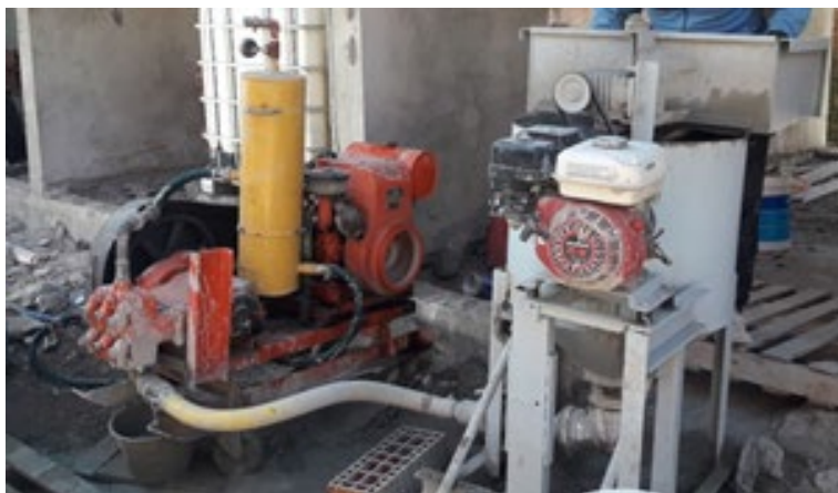
Figura 35.7: Mezclador y bomba de inyección de lechada de cemento (GEF: Consultoría en Geotecnia, Estructuras y Fundaciones)
