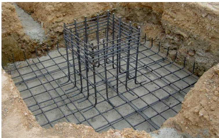
Figura 13.5: Zapata individual – Armado previo al colado de hormigón
