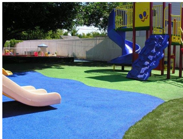
Figura 6: Piso de caucho reciclado in situ
