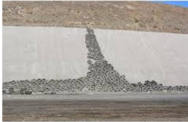
Figura 7 Uso de neumáticos fuera de uso en terraplenes.
