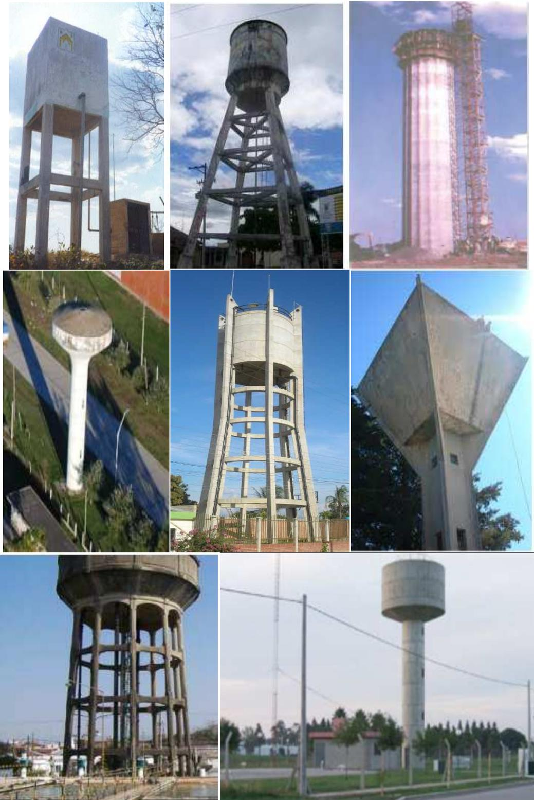
Figura nº09-01: Imágenes de tanques elevados de Hormigón Armado
