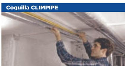
Imagen 1. Montaje coquilla CLIMPIPE Section Alu 2.
