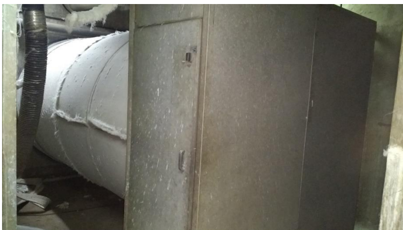
Imagen 2, vista desde el túnel de retorno a un filtro rotativo
