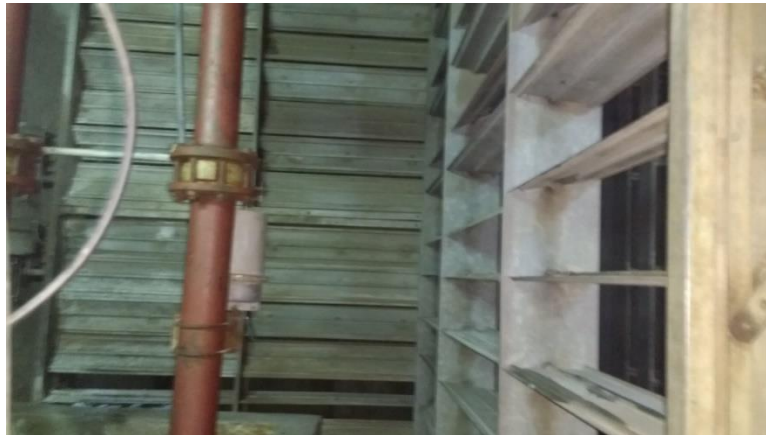
Imagen 7, vista desde la sala de humectación, las persianas de mezcla de aire
