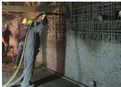
Fig. 3. Hormigón proyectado sobre muro.
