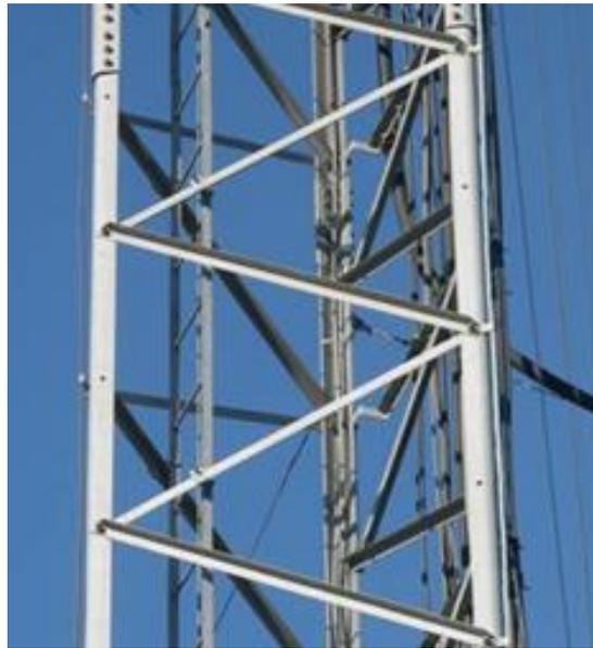
**Fig. 3.** Mástil reticulado con diagonales en zig-zag.
