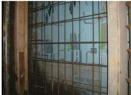
Fig. 2. Armadura distribuida como parte de la estrategia de refuerzo.
