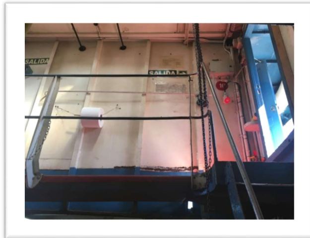
18 puerta de ingreso a sala de máquinas
