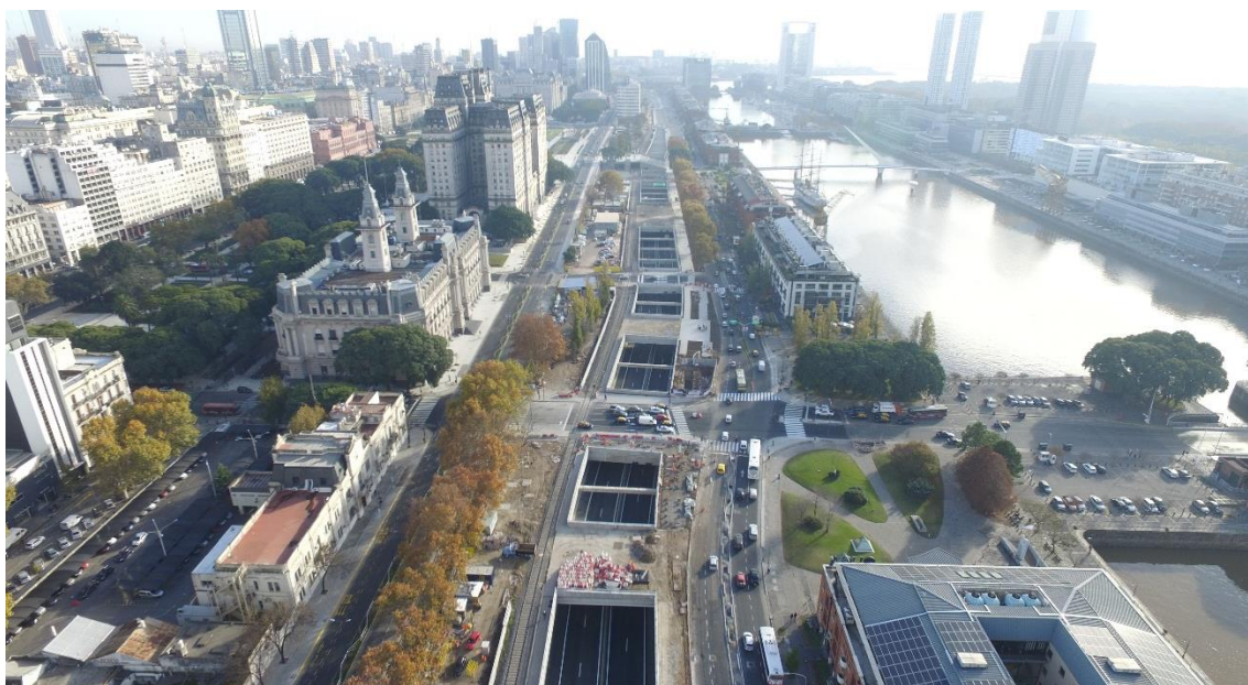
Figura 6-14: Fotografía aérea de trinchera. Sectores abiertos y techados en puentes
