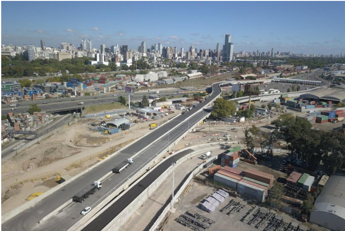
Figura 6-8: Fotografía aérea del Distribuidor Norte
