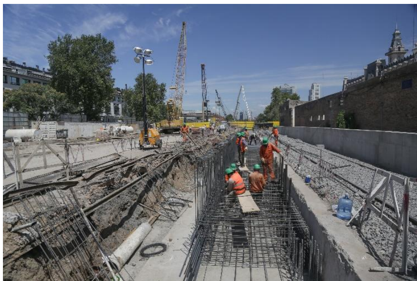
Figura 6-18: Imagen de la construcción de viga de coronamiento
