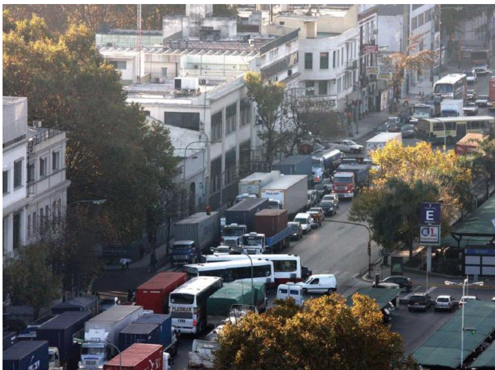
Figura 3-4: Estado de av. Huergo previo a la ejecución de la obra del Paseo del Bajo (Fuente Revista Carreteras N° 198 – Agosto 2010)
