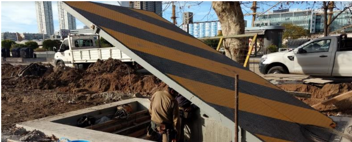
Figura 6-35: Imagen de salida de emergencia tipo “compuerta”
