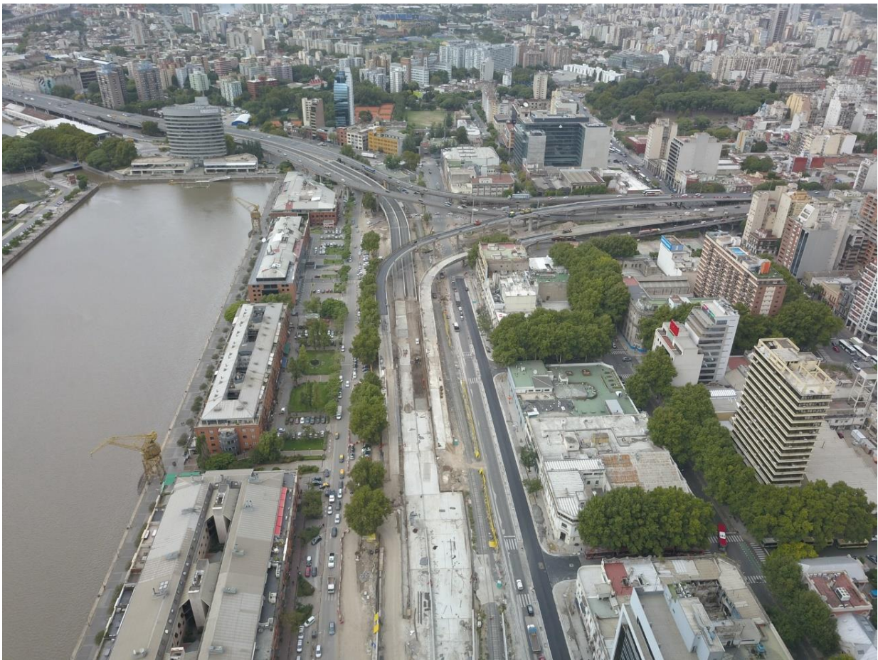
Figura 6-4: Fotografía aérea del Distribuidor Sur
