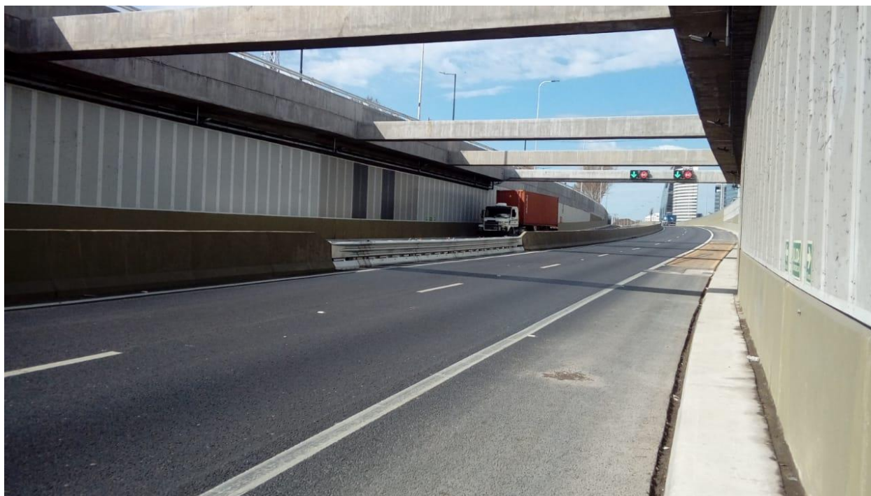
Figura 6-32: Detalle de barrera móvil en defensa central
