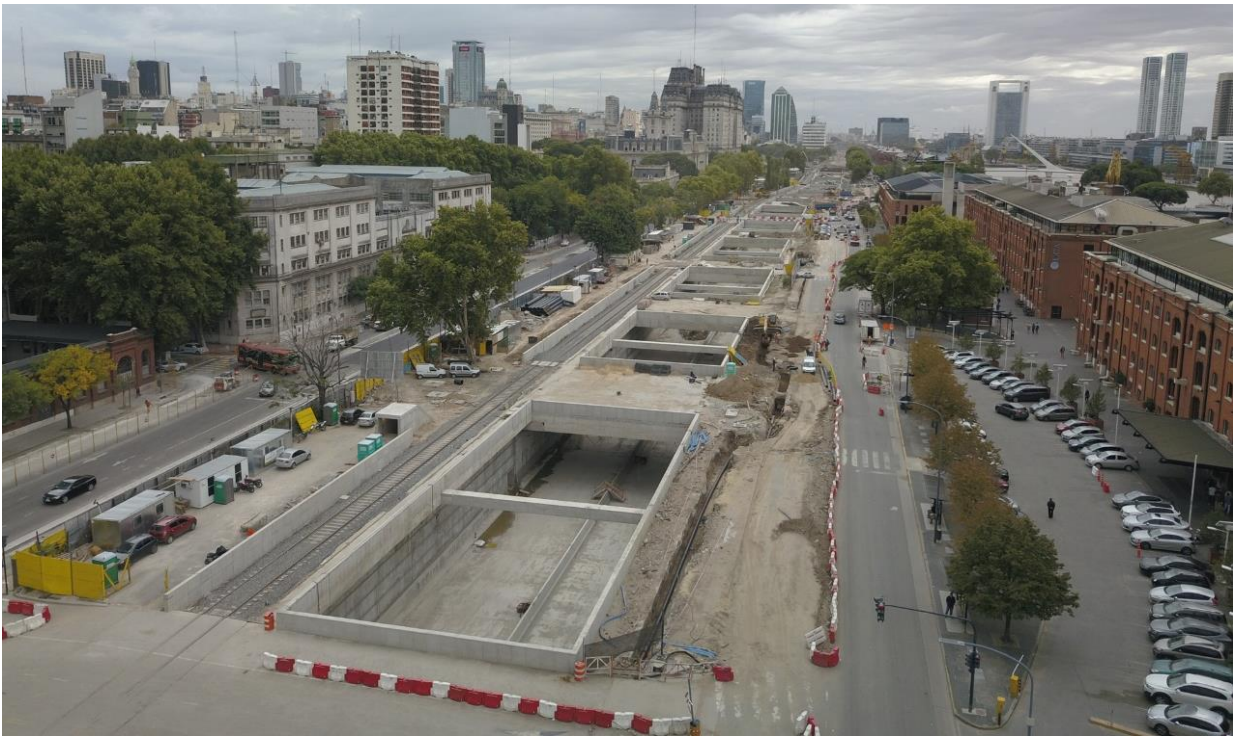
Figura 6-15: Fotografía aérea de trinchera. Sectores abiertos y techados en puentes (en construcción)
