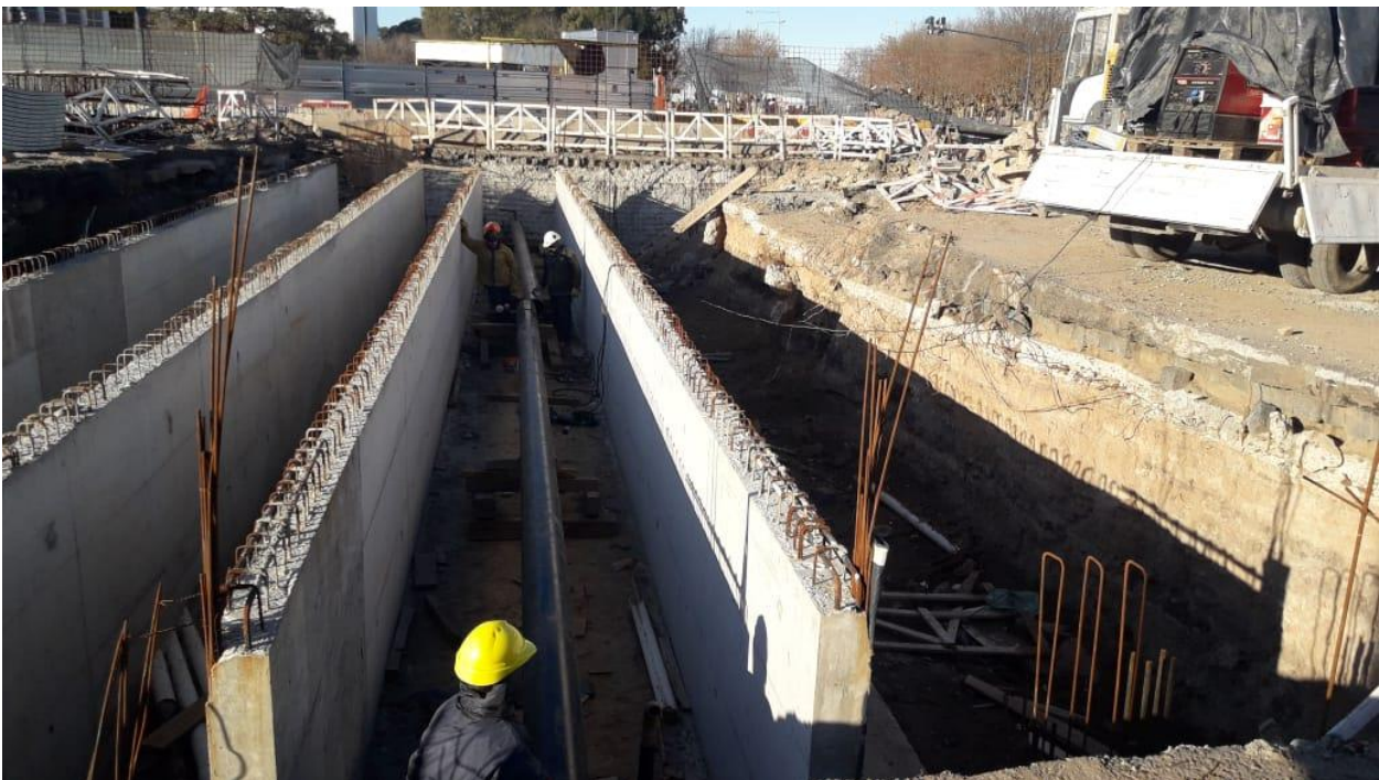
Figura 6-28: Imagen de la cañería dentro de una de las vigas cajón (en construcción)
