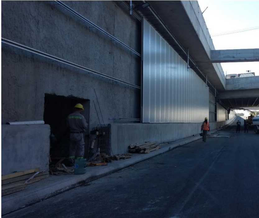
Figura 6-38: Imagen del revestimiento lateral en trinchera
