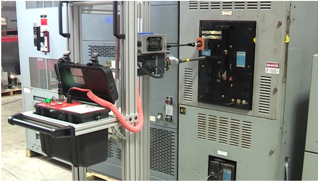
Figura 59. Sistema remoto de inserción y extracción de interruptores marca CBS en acción. Fuente: FONKEL MEXICANA.
