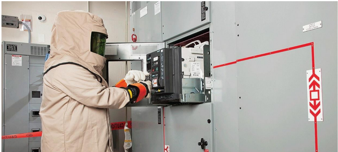
Figura 16. Operario trabajando con el EPP. Fuente: Revista Megavatios.
