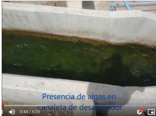
**Figura 4** Captura de video de presencia de algas en la canaleta de desarenador de la planta de tratamiento de aguas de la SCPL (Acueducto Lago Musters SCPL - Video de YouTube, 2014)
