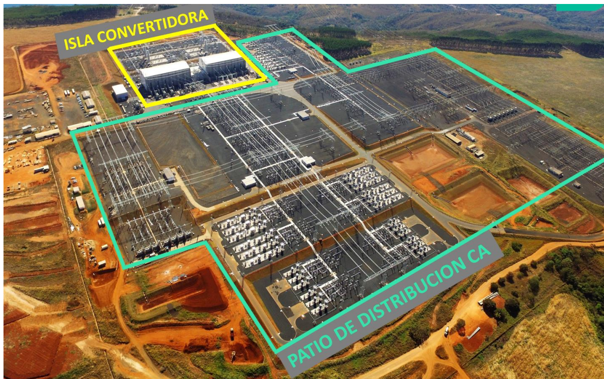
(Fig. 12-1) Estación conversora Xingu-Estreito
