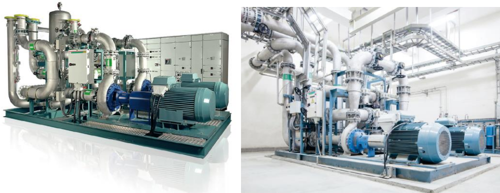
(Fig. 18-4) Sistema de refrigeración – HVDC Jingzhou Huizhou
