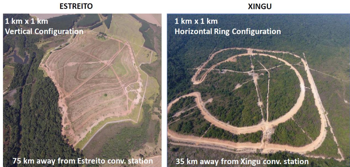
(Fig. 8-1) Electrodo de Tierra Estación Xingu-Estreito 800 kV 4000 MW
