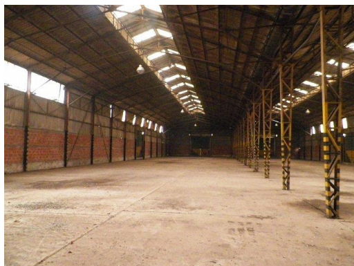
Imagen: Interior de la nave industrial
