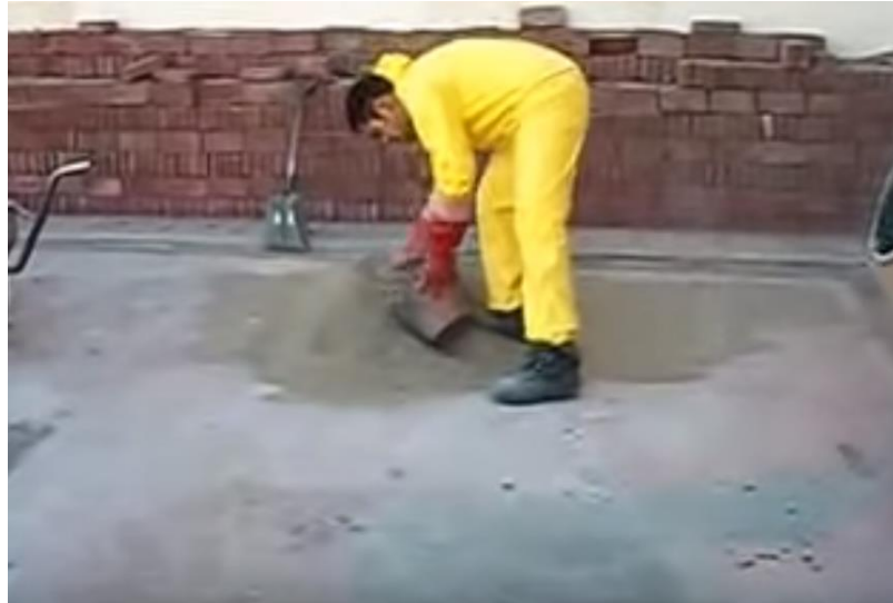
Foto 14: Arena Mediana, para dar terminación y volumen. Fuente: Cooperativa Valle del Conlara.
