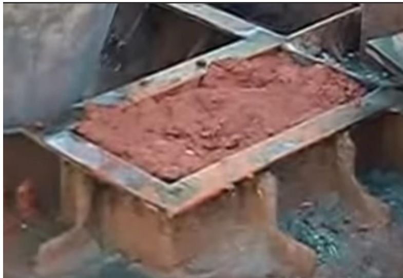
Foto 18: Mezcla colocada en una conformadora de ladrillo manual. Fuente: Cooperativa Valle del Conlara.
