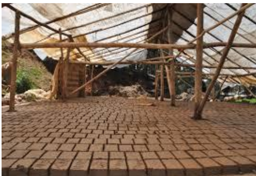
Foto 22: Alternativa de cancha de secado de ladrillo. Fuente: Cooperativa Valle del Conlara.
