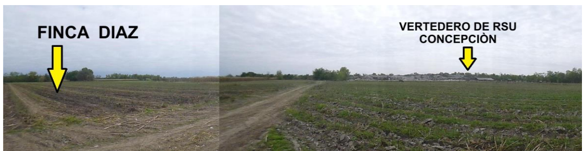
Foto 8: Vista Panorámica sobre el actual Sitio de Disposición Final de RSU y sobre el Sitio en estudio. Fuente: Dr. Rubén I. Fernandez
