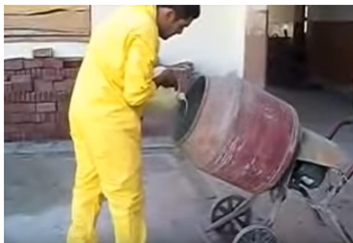
Foto 16: Armado de la Mezcla. Fuente: Cooperativa Valle del Conlara.
