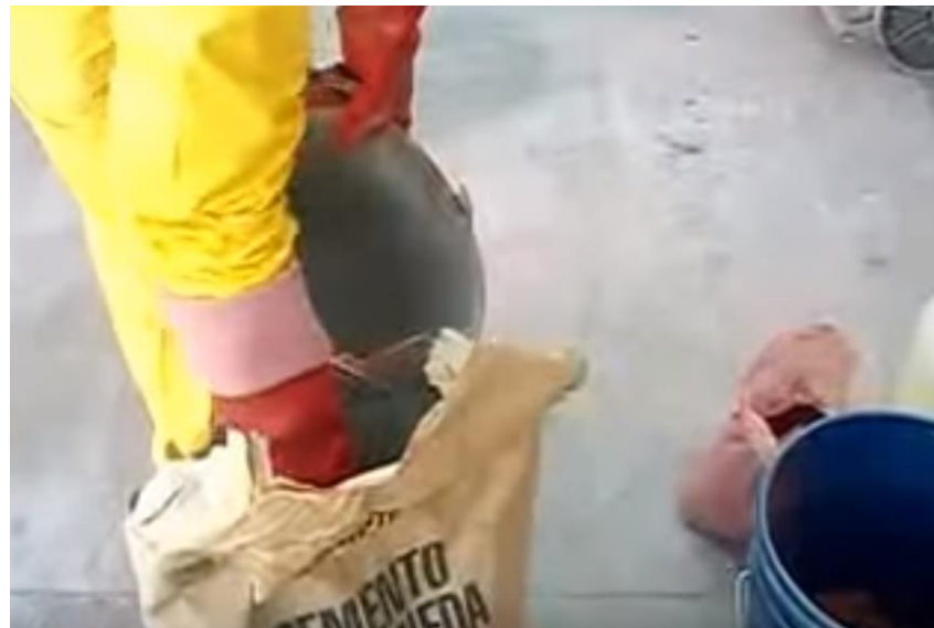
Foto 13: Cemento para incorporar dureza y resistencia. Fuente: Cooperativa Valle del Conlara.
