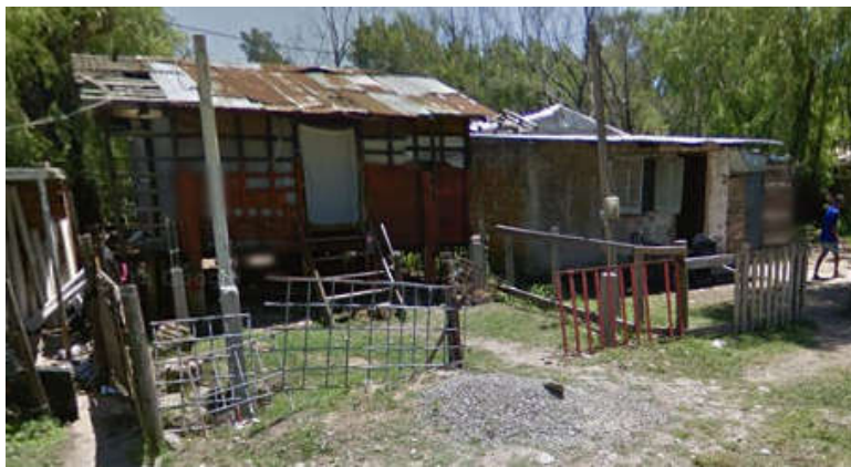
Ilustración 18 Estado de viviendas precarizadas.
