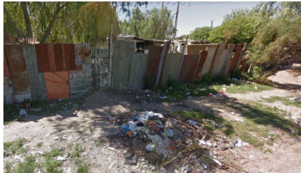
Ilustración 17 Estado de vivienda precarizada.
