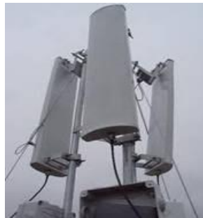
Ilustración 4 (antenas sectoriales) 76
