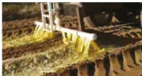
Figura 3. Distribución en obra del desgomado de soja diluido.
