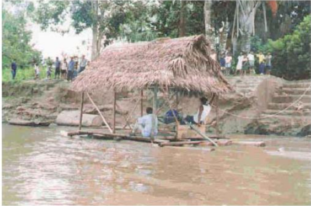
Figura 2.9 Instalación actual de la turbina de río. Copyright 2005 por Maldonado. Reimpreso con permiso.
