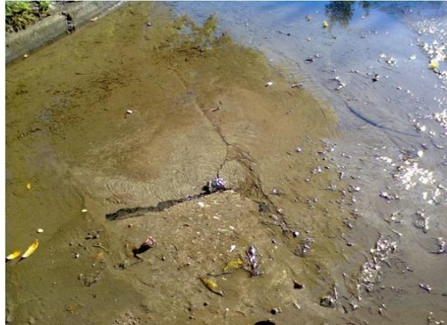
**Figura 25:** Flujo de agua por medio de fisuras encontradas sobre la misma calzada
