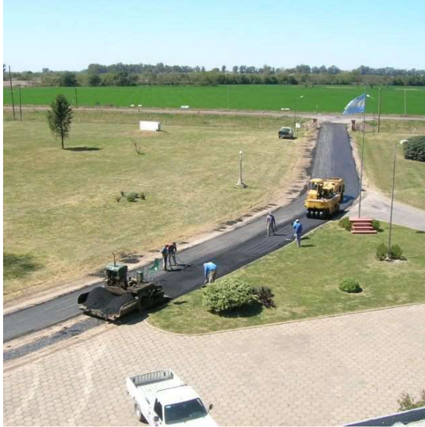
Figura III.4: Pavimentación de caminos internos. Fuente: INTA, 2018.
