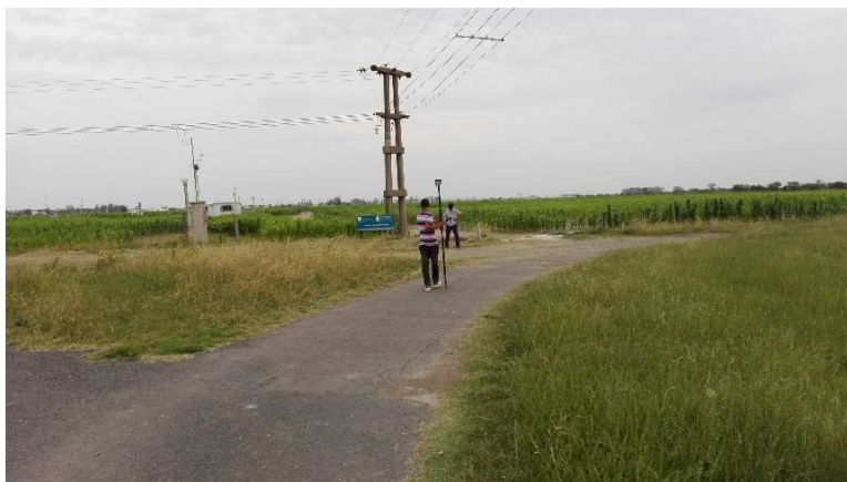
Figura IV.10: Realización de relevamiento topográfico. Fuente: elaboración propia, 2018.
