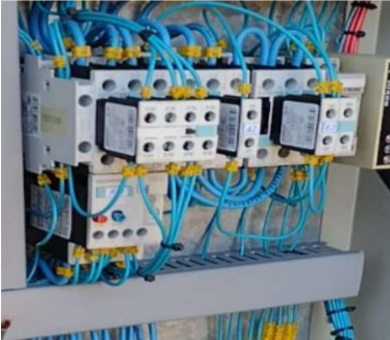
El arranque estrella-triángulo, es el más utilizado de todos los métodos a tensión reducida, por lo simple de su construcción, su relativo bajo costo y su confiabilidad.
