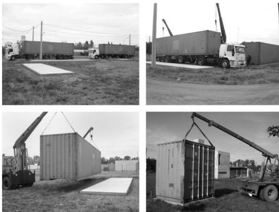
Figura 8- Montaje vivienda container. Fuente: [www.arquimaster.com.ar](http://www.arquimaster.com.ar)
