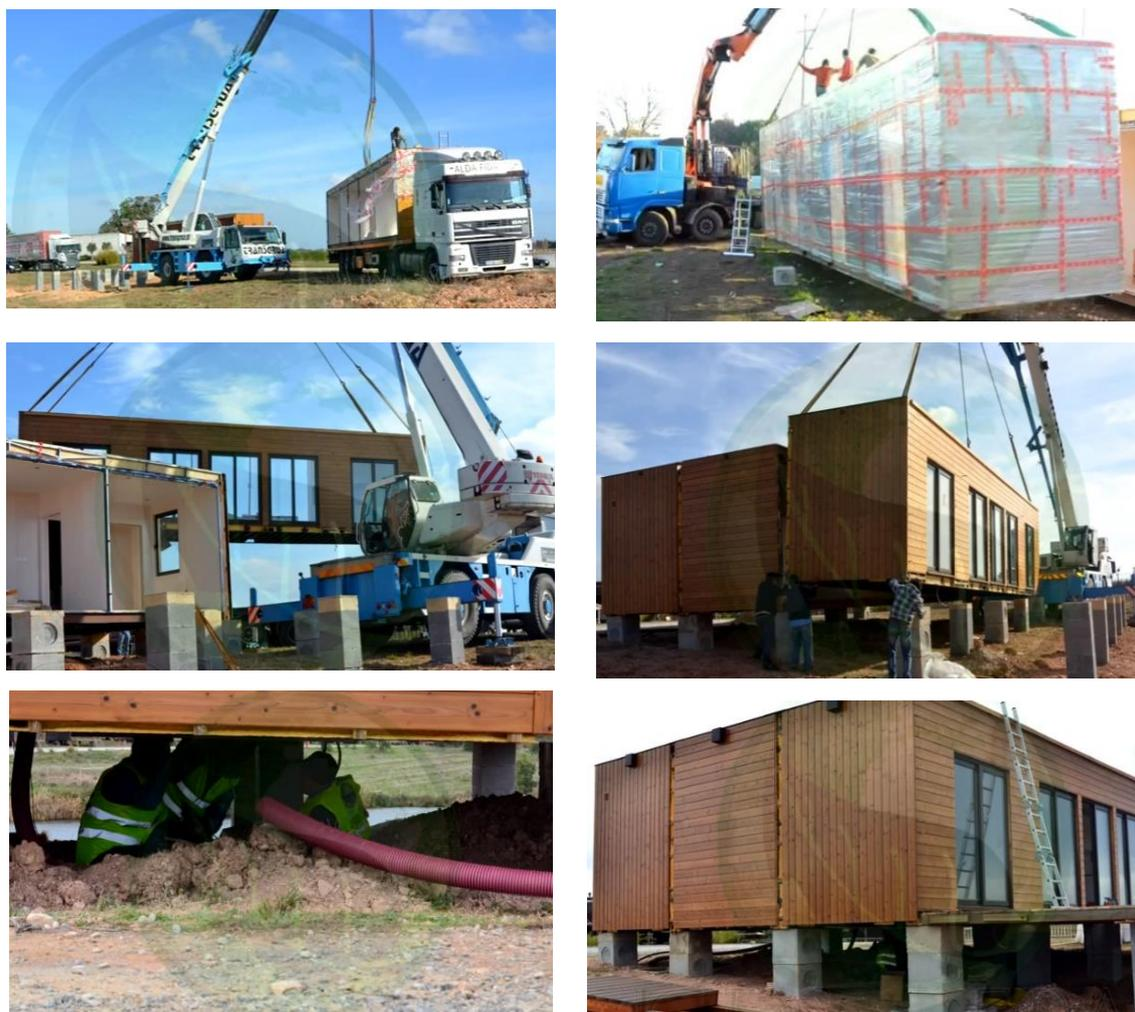
Figura 14- Secuencia de traslado y montaje en obra. Fuente: [www.arquitecturayempresa.es](http://www.arquitecturayempresa.es)
