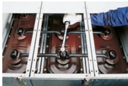
MC-MT Ilustración 2.1 - Conexión entre celdas contiguas - Fuente: Schneider
