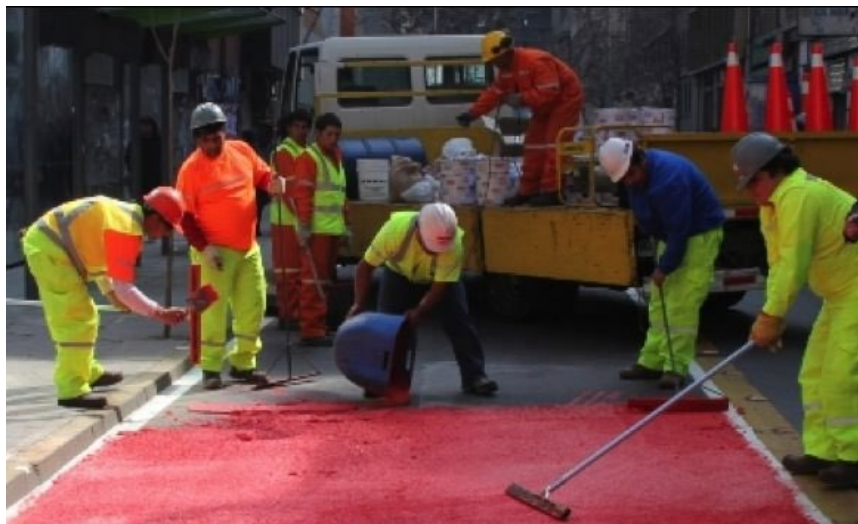
Figura 2-5 Aplicación Manual de Plástico en Frío
