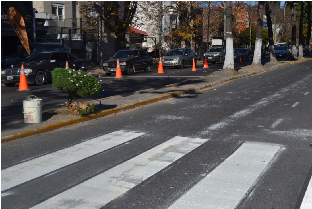
Figura 5-16. Marca en el pavimento luego de la habilitación de las franjas Fuente: elaboración propia
