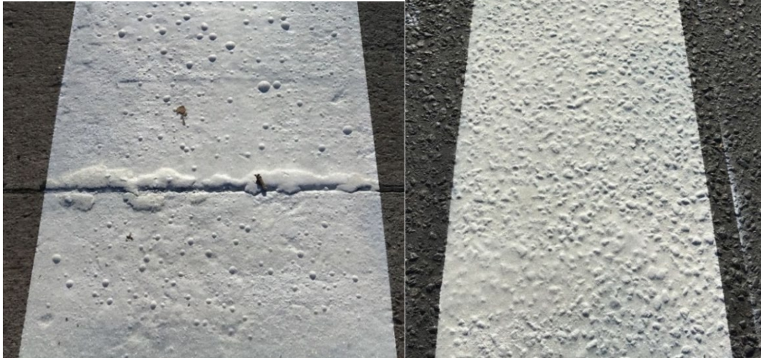
Figura 5-18. Izq.: Pintura S1 en pavimento de Hormigón; Der.: Pintura S1 en pavimento asfáltico
