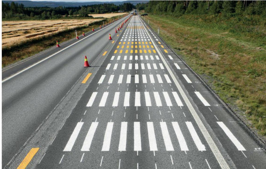
Figura 1-3. Campo de ensayo.
