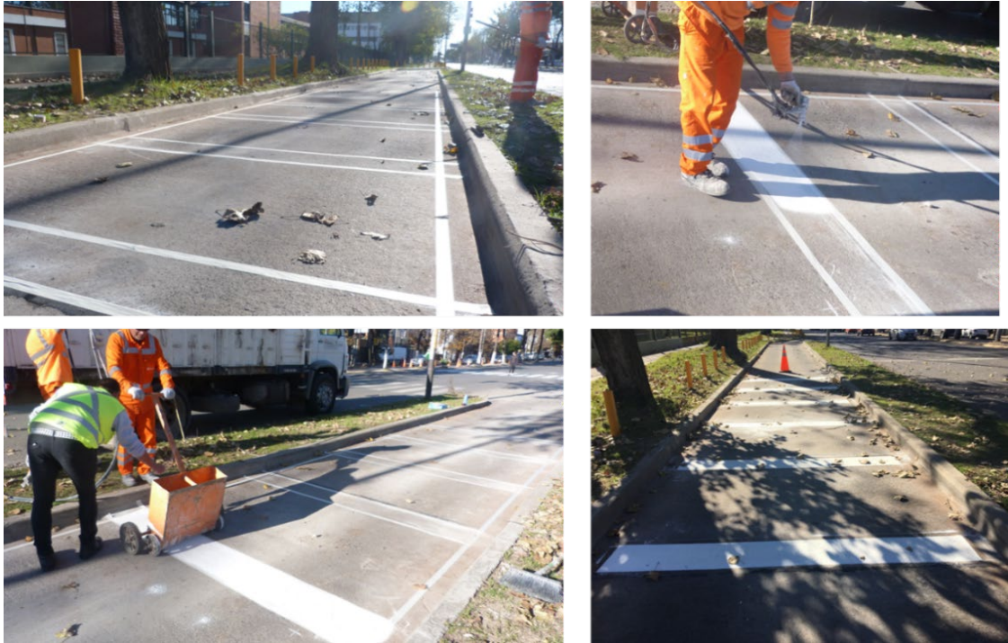
Figura 5-10. Pintura de Franjas sobre dársena de ingreso a la UTN FRLP
