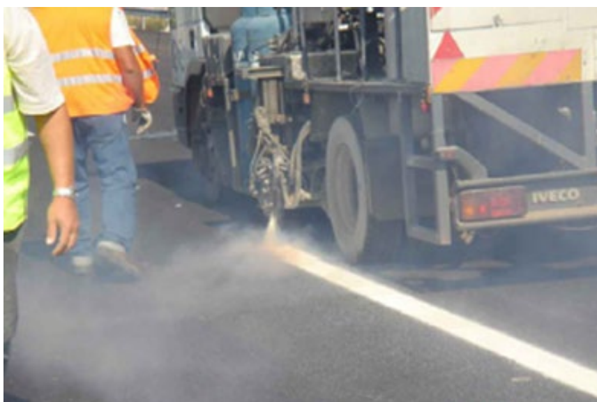
Figura 2-2. Máquinas de aplicación de Termoplástico por Pulverización
