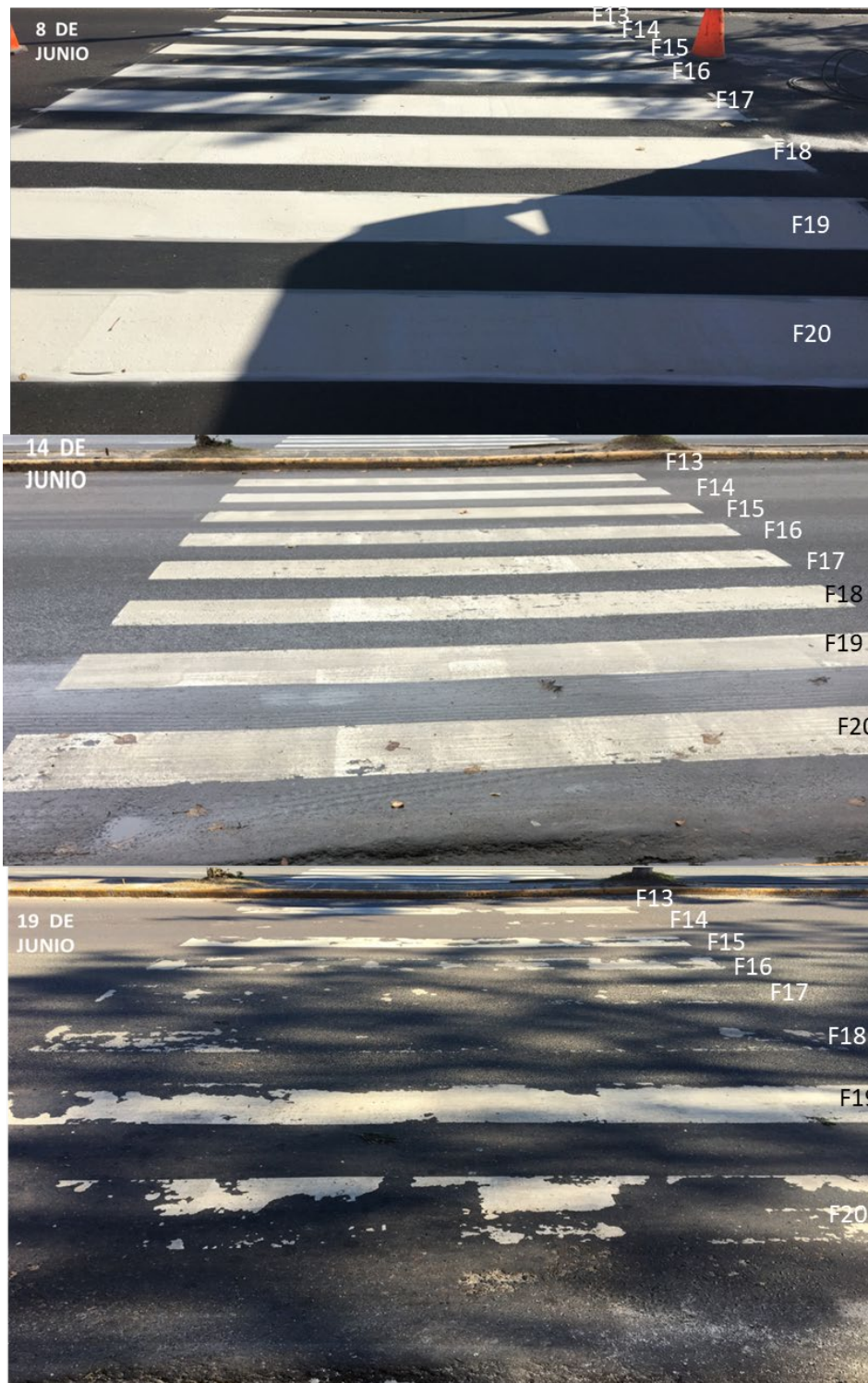
Figura 5-29. Secuencia de fotos en la senda peatonal con pintura A3
