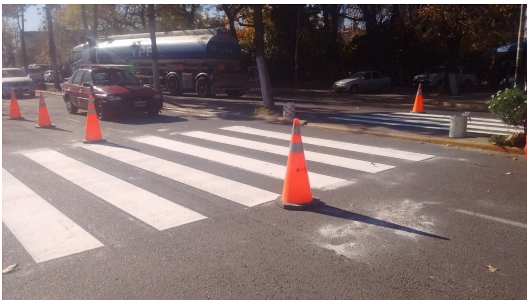
Figura 5-15. Senda peatonal momentos previos a la habilitación de las franjas
