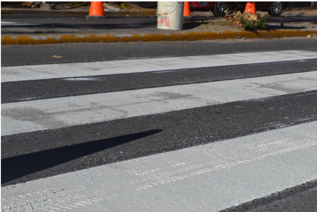
Figura 5-17. Marcas en la pintura por el paso de los vehículos Fuente: elaboración propia
