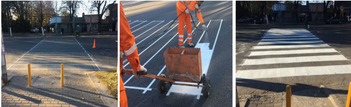
Figura 5-8. Aplicación de la Pintura S1 sobre la senda peatonal mano a La Plata
