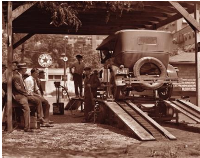
Fig. 1.6 – Dinamómetro de Rodillos (Año 1924)
