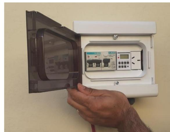
Figura 2. Tablero con temporización utilizado.
