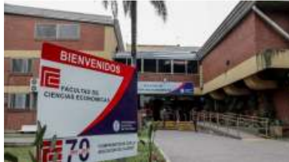
Figura 15: Fotografía de fachada principal de la FACE U.N.T. 3 de Julio de 2020.
