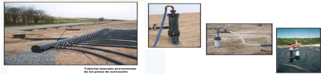
Figura 31. Fotos colectores y cabezales para extracción de biogás en un vertedero controlado. Captación vertical (Weihs, 2011).
