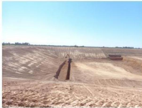
Figura 28. Preparación de suelo para la instalación de nuevas celdas de relleno sanitarios.
