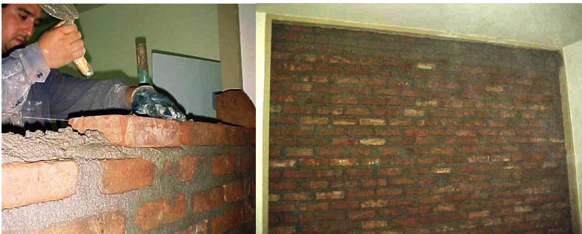
Figura 9. Vista del proceso de construcción del material bajo estudio N° 3: Muro construido con ladrillones.
