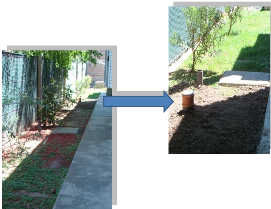
Figura 3: Fotografía de la zona correspondiente al lecho filtrante y lugar de toma de muestra de efluente final.
