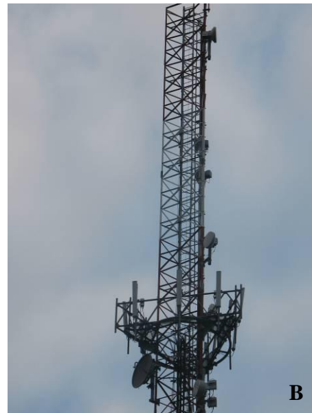
Figura 6: Tipos de antenas de telefonía móvil: A Torre de antena monoposte. B Torre de antena reticulada.
