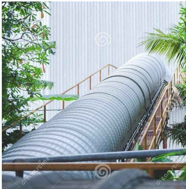
Ilustración 1: Transportador de banda cubierto.
