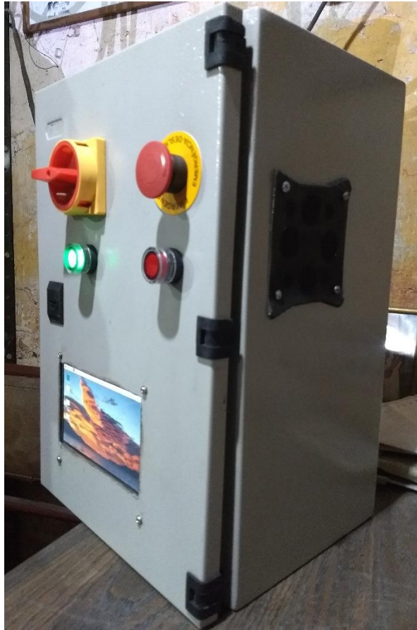
Figura 65: Vista externa del tablero finalizado.
