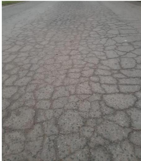
**Fig. 1.** Agrietamiento de pavimento asfáltico asociado a la falla por fatiga
