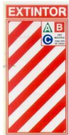
Fig. 30: Señalización de extintores
