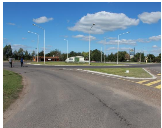
Figura 4.1.2.e': Acceso A5 - Intersección RP 39 y calle Raúl Alfonsín Fuente: propia
