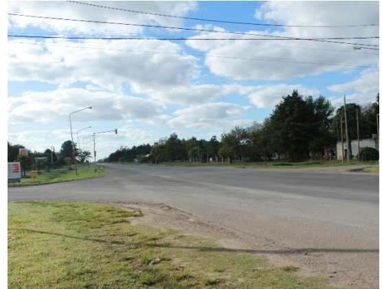
Figura 4.1.2.c': Acceso A3 – intersección RP 39 y calle Dante Alighieri Fuente: propia
