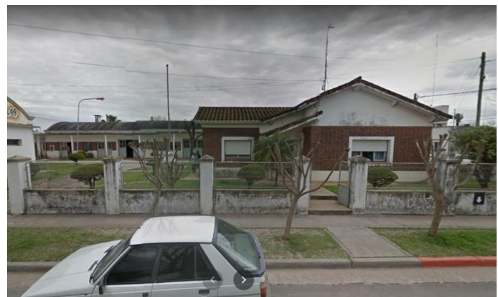
Figura 4.2.2.b: Ubicación actual de oficinas de obras sanitarias Fuente: propia
