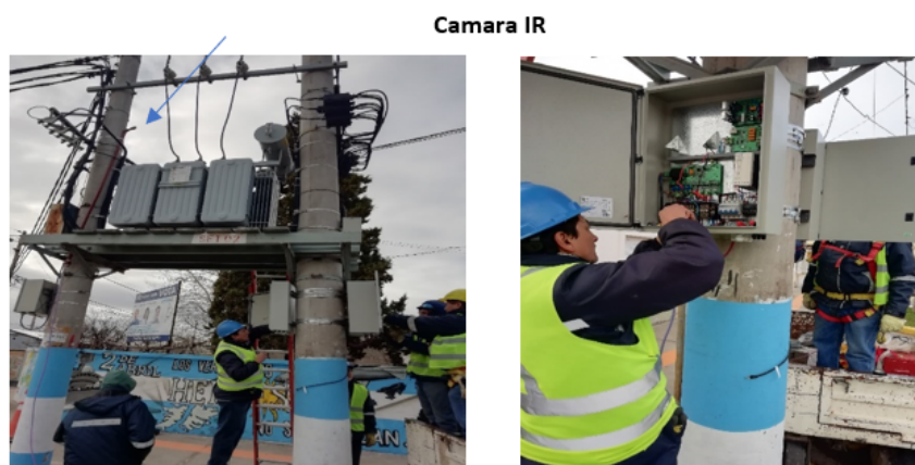
FIGURA 18 Instalación del equipo en la SET.
