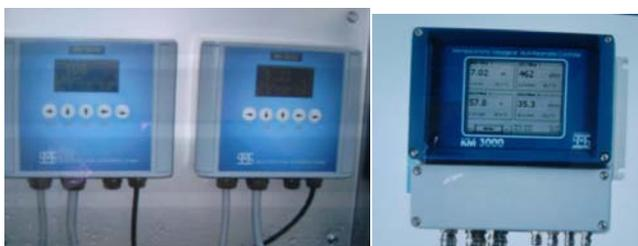
**Figura 40: Equipo para medición y control de temperatura, pH y redox**
