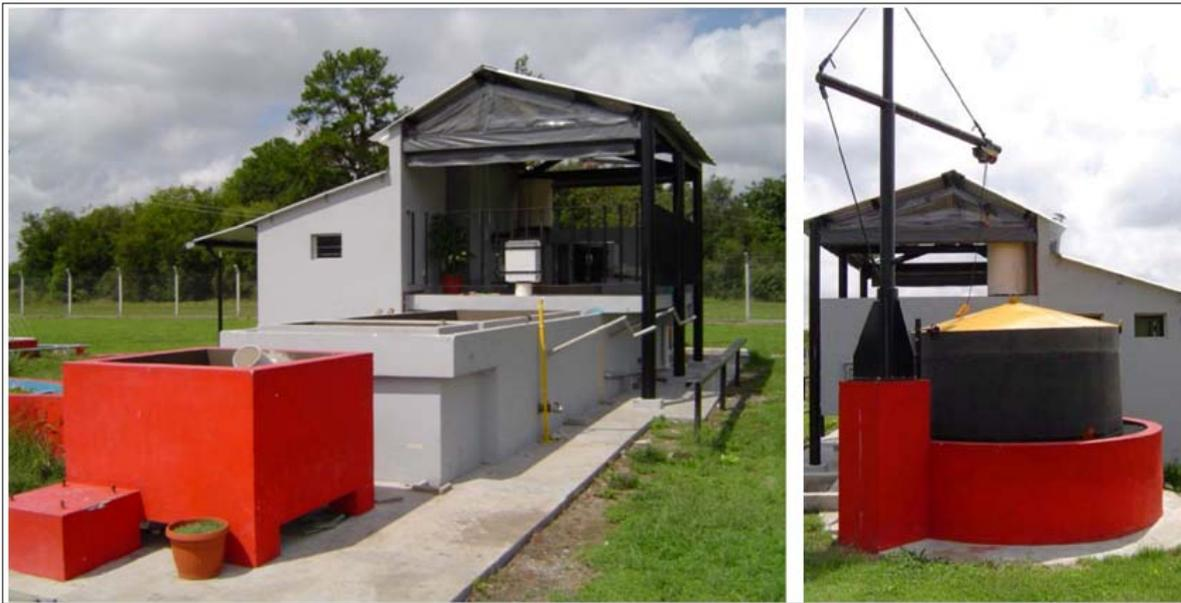
**Figura 18. Digestor anaeróbico para la transformación de FORSU.**
