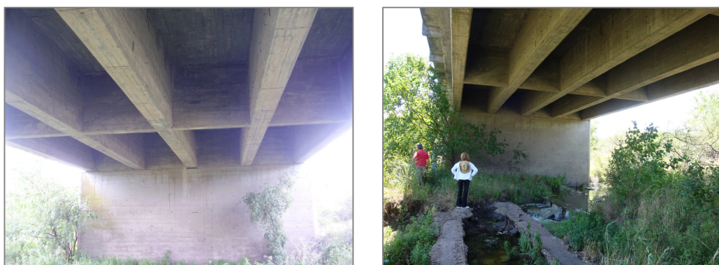
Fig. 14 Vista de las vigas longitudinales.
