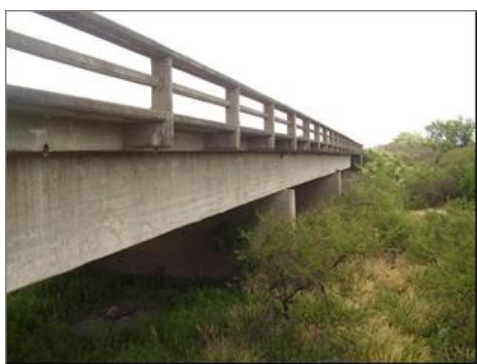
Fig. 4 Vista lateral, donde se puede observar los desagües.
