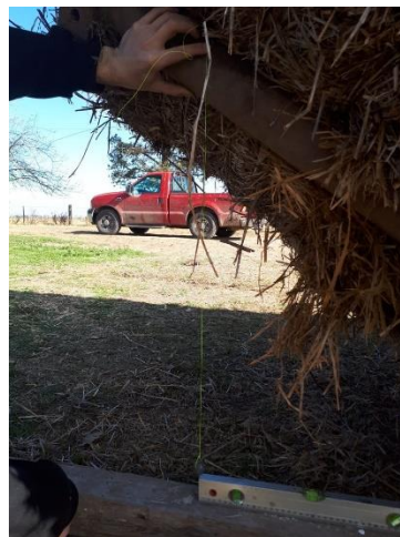
Ilustración 39. Plomada para lograr perpendicularidad
