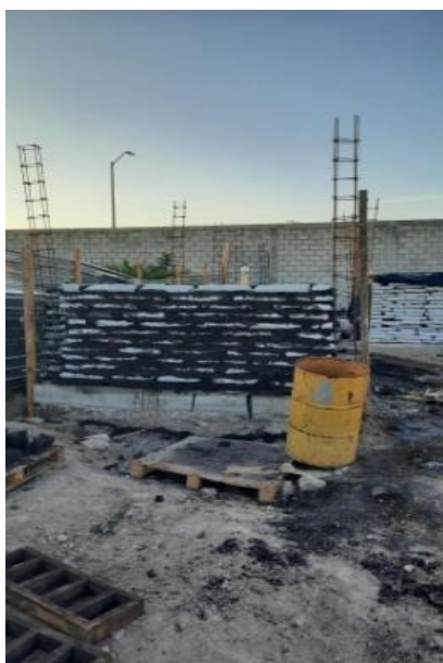
Figura 2. Levantamiento de muros
