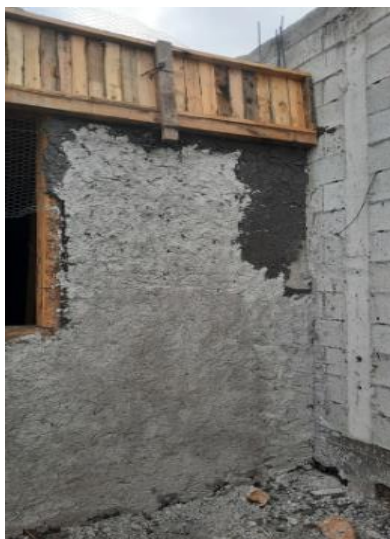
Figura 6. Revoque de paredes exteriores
