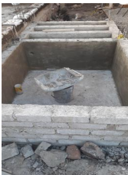
Figura 3. Losa del biofiltro y cisterna
