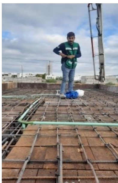
Figura 5. Preparación de cimbra
