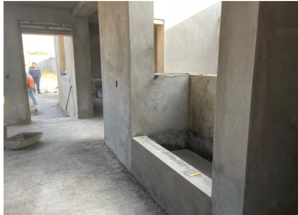
Figura 8. Revoque de paredes interiores
