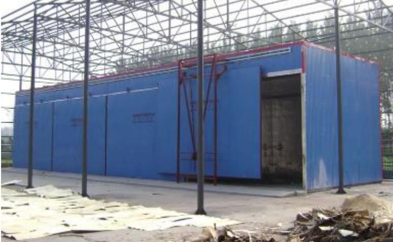
La cámara de secado será de 6 x 6,5 x 4,5 metros de altura ya que la madera debe ser apilada de manera separada vertical y horizontalmente para permitir el flujo de aire correcto dentro de la cámara.
