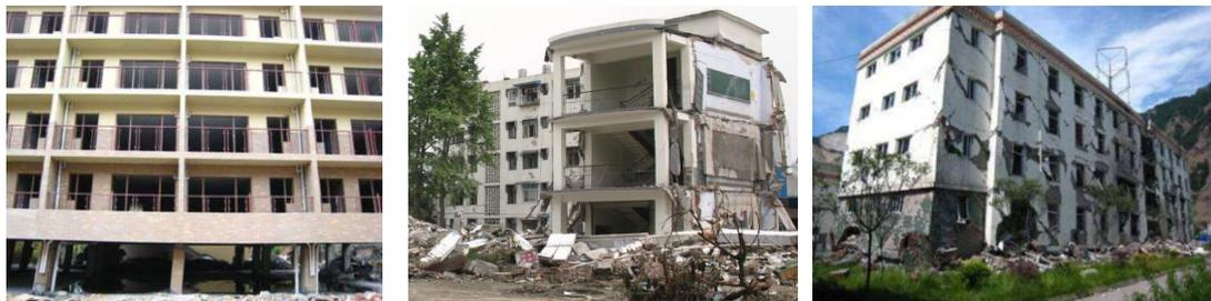
Figura 1.1. Daño estructural en el terremoto de Wenchuan (Miyamoto, 2008).
