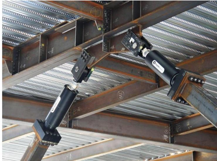
Figura 2.18. Dispositivos viscoelásticos utilizados por la empresa *Taylor Device Inc.* (2019)
