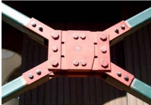
Figura 2.17. Dispositivo de fricción desarrollado por Pall. Marsh & Fazio (1980)
