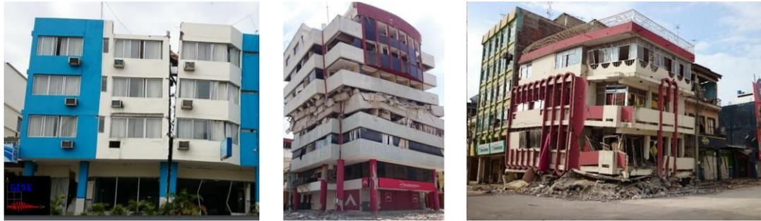
Figura 1.3. Daño estructural en el terremoto de Ecuador 2016 (Aguiar & Bravo, 2016).
