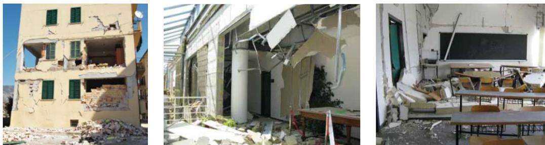
Figura 1.2. Daño estructural en el terremoto de L'Aquila (Miyamoto, 2009).
